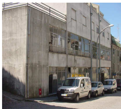
Sede da FAJDG antes das obras
