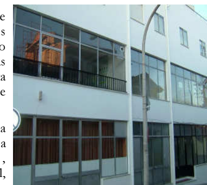
Sede da FAJDG depois das obras
